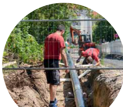
4 ZIELGRUBE, VORBEREITUNG DES EINZIEHVORGANGS
